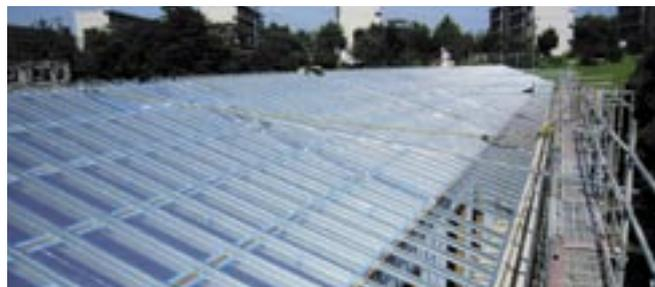
スタイロラスター：スタイロフォームに表面放射率の低い(反射しやすい)特殊なアルミ箔を使い、夏場の日差しから住宅内に入る熱量の大幅な低減を実現する新商品
