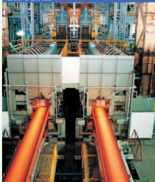
連続鑄造設備
