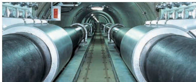
写真3 専用シールド内パイプライン
