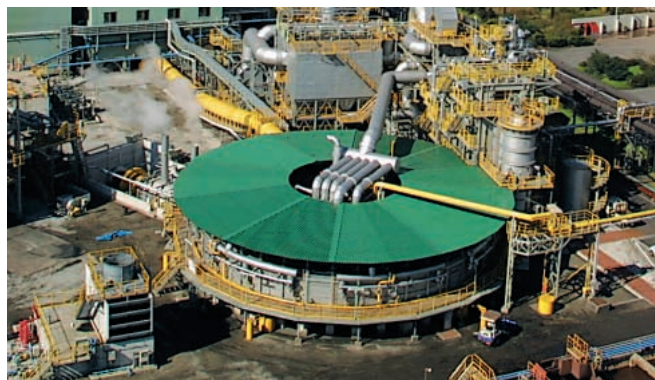
写真2 回転炉床炉(RHF)
