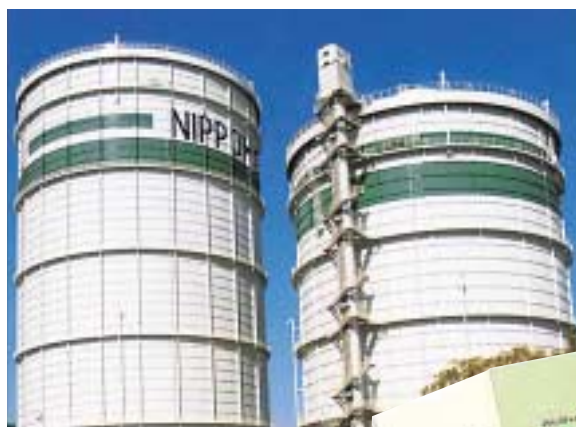
新設したガス化ホルダー（名古屋）
