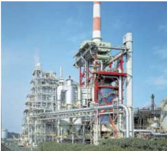
コークス乾式消化設備（CDQ：Coke Dry Quenching）乾留後の赤熱コークスを水で消火せず、窒素ガスなどで消火するとともに、顕熱を回収する大型排熱回収設備。
