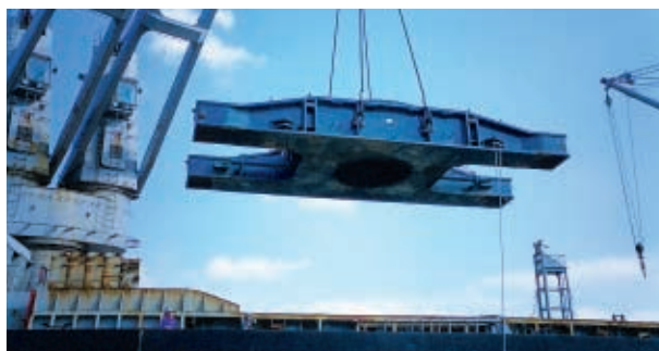
プラント貨物の船積み作業
