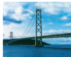
明石海峡大橋
