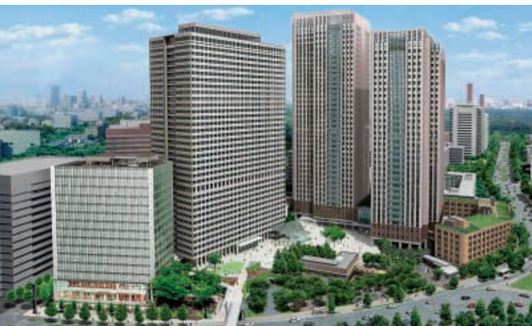
（2007年9月建物竣工予定）
