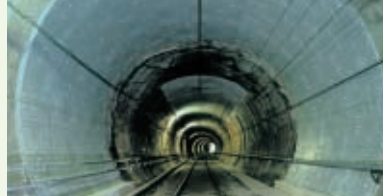
写真4 トンネル薄肉鋼製補強(TUK)工法
