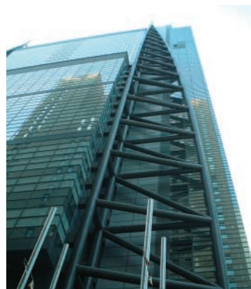
外部露出仕様・円形鋼管仕様 2003年 日本テレビタワー(東京)
