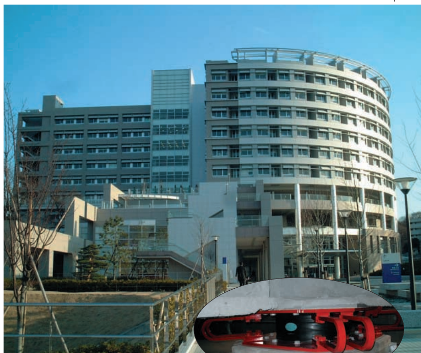
積層ゴム一体型免震U型ダンパー使用 2001年 君津中央病院(千葉県)
