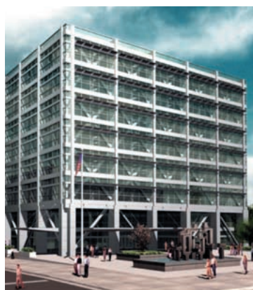
外部露出寒冷地仕様 2001年 米国連邦政府ビル耐震補修 (ソルトレークシティ)
