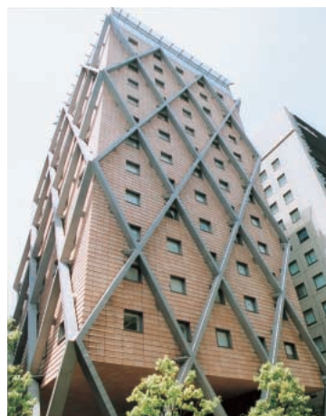
外部露出仕様・矩形鋼管仕様 1997年 ㈱SANKYO新東京本社ビル(東京)
