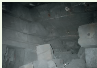
解体調査： 発破直後の炉底耐火物の様子（大分2高炉）
