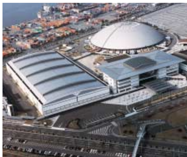
図3 スーパーステンレス鋼の屋根 写真1 （名古屋国際展示場）
