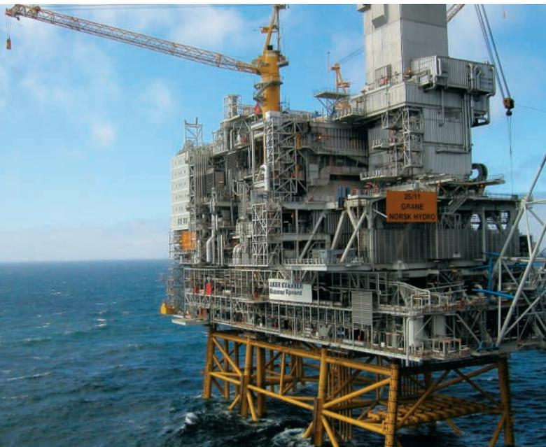
HTUFFが採用された海洋構造物 石油や天然ガスを掘削する海洋構造物へのHTUFF適用で、建造コストを大幅に削減
