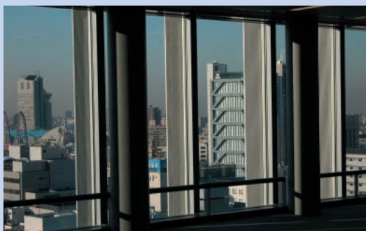
構造を支える鋼管柱 (内部)
