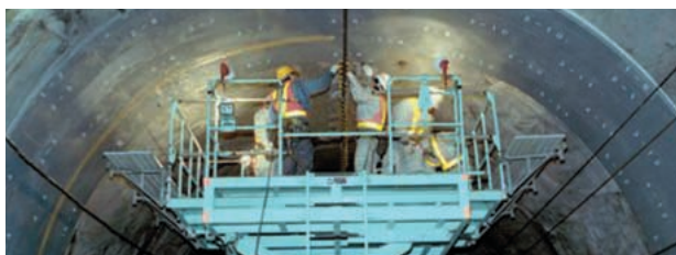
写真2 補強板組立 作業状況
