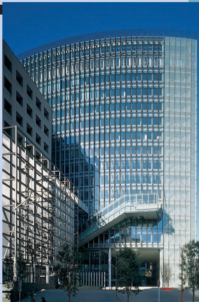
ファサード Photo：大野 繁 (写真家)
