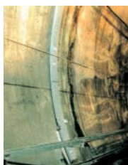
写真1 ゲージリング 設置状況
