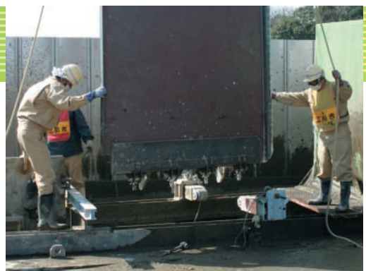
図1 汚染土壌からの有害物質流出防止（原位置封じ込め）
