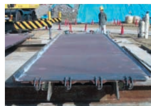
図5 遮水パネルの施工
