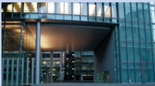
11mの鋼管柱が貫通するエントランス
