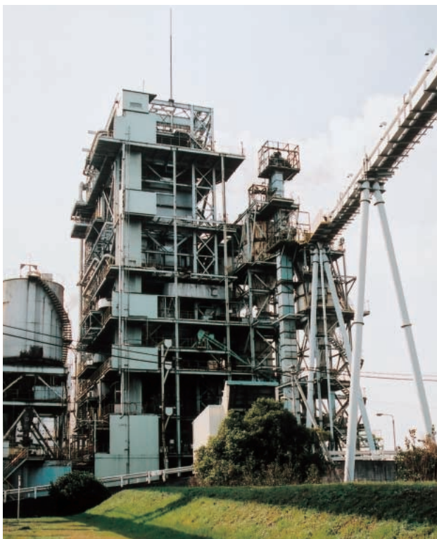
広畑製鉄所1号ボイラー (CFB)
