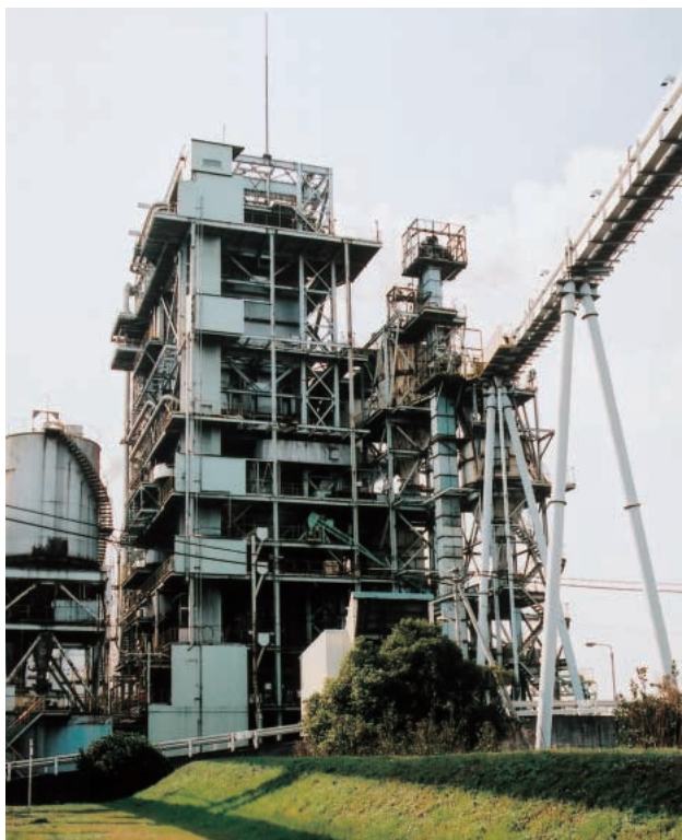
広畑製鉄所1号ボイラー (CFB)
