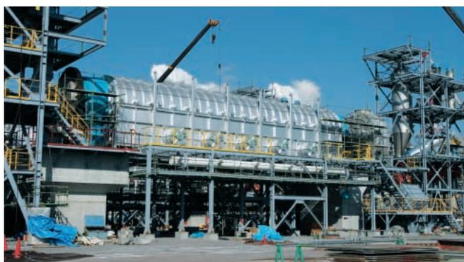
建設中の廃タイヤガス化リサイクル施設(外熱式キルン)
