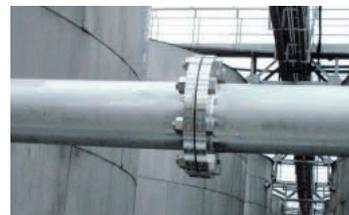
写真3 食品加工装置に使用されたYUS270の配管およびフランジ
