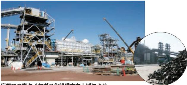
広畑での廃タイヤガス化設備立ち上げにより、日本全国で発生する廃タイヤの約1割以上(12万トン/年)を処理する計画。
