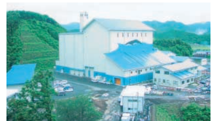
高知西部環境施設組合轄多クリーンセンター(高知県)
