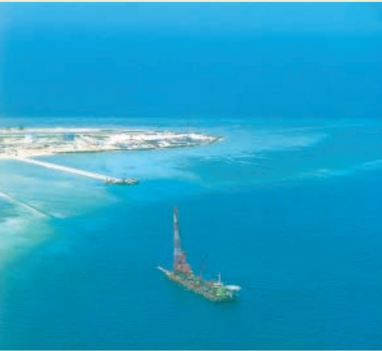
PERTAMINA/イーストジャワ パイプライン
