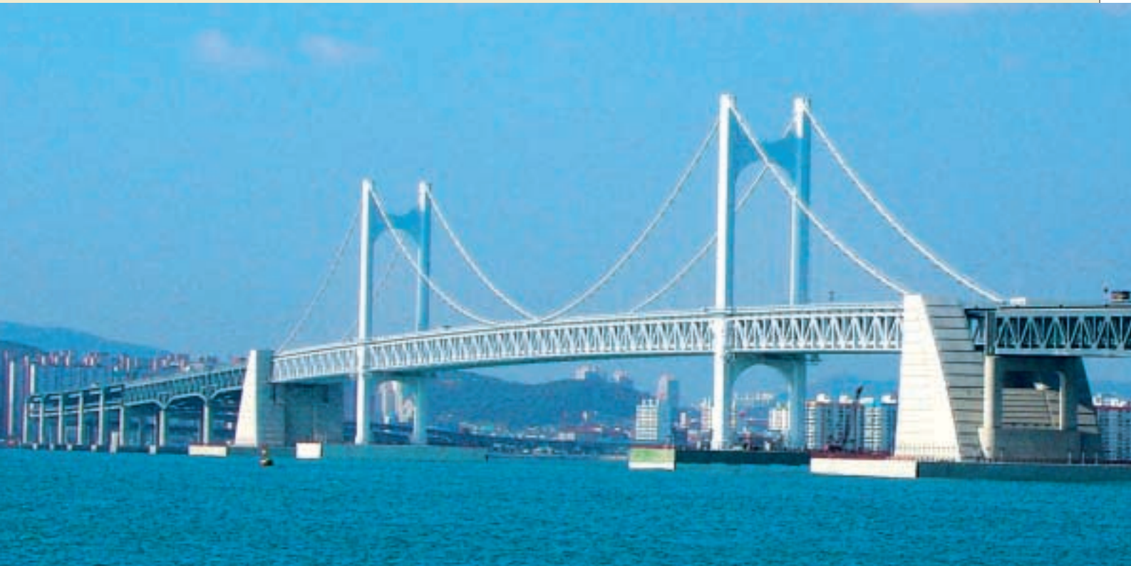
広安大橋（韓国・釜山）
