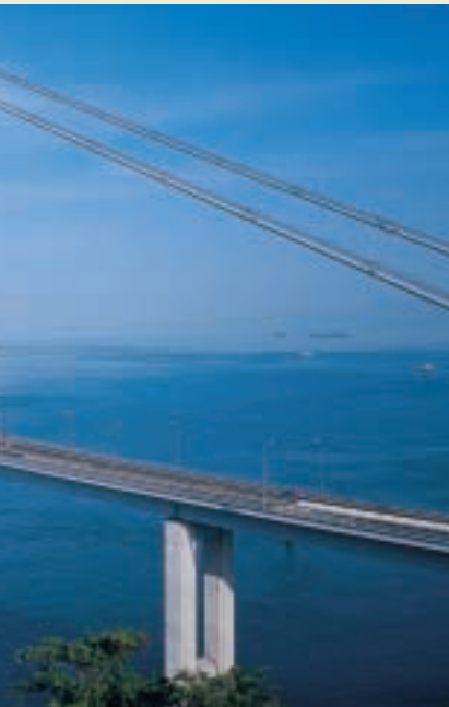
本州四国連絡橋公団/来島大橋（愛媛県）
