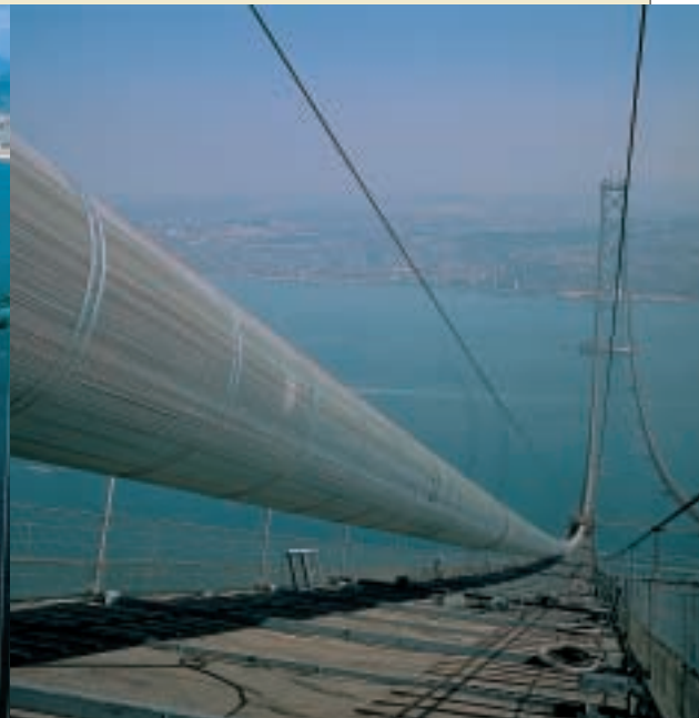
主ケーブル（明石海峡大橋）
