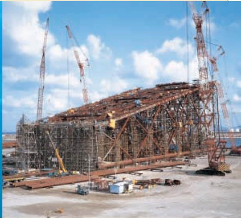
エッソ石油開発㈱いわき沖プラットフォーム用ジャケット
