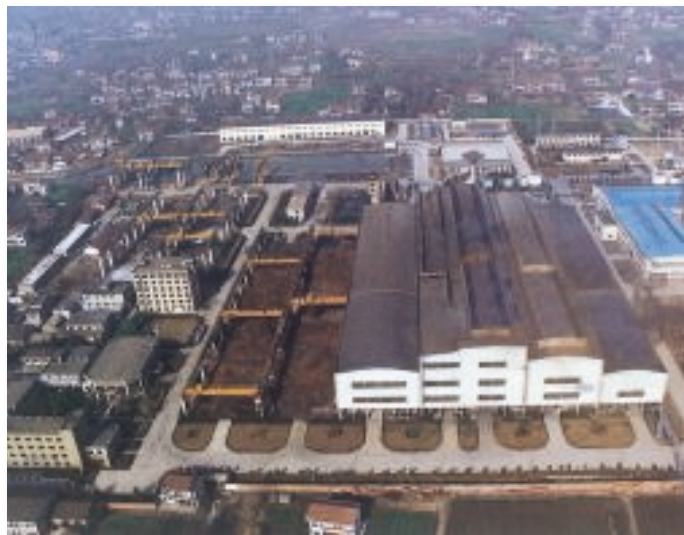
◆南通宝鋼新日製鋼有限公司（電炉・棒鋼一貫設備による棒鋼の製造・販売） 新日鉄、三井物産、上海宝鋼集团公司、南通市投資管理中心の合弁会社（1994年設立）。
