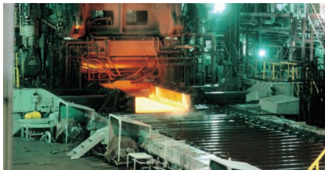
八幡厚板工場 / 仕上げ圧延機
