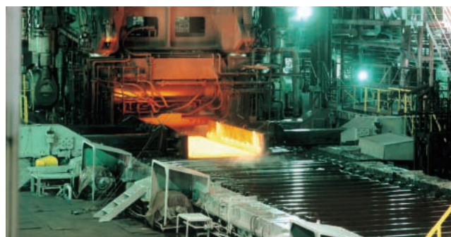
八幡厚板工場／仕上げ圧延機
