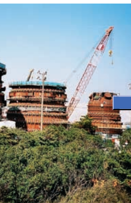
地組場で組み立てられた新マンテル群。手前から炉底マンテル、シャフトマンテル、ガス捕集マンテル。
