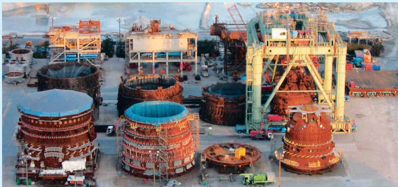
大ブロック工法で搬出された旧マンテル(後方)と、搬入・設置を待つ新マンテル(前方)
