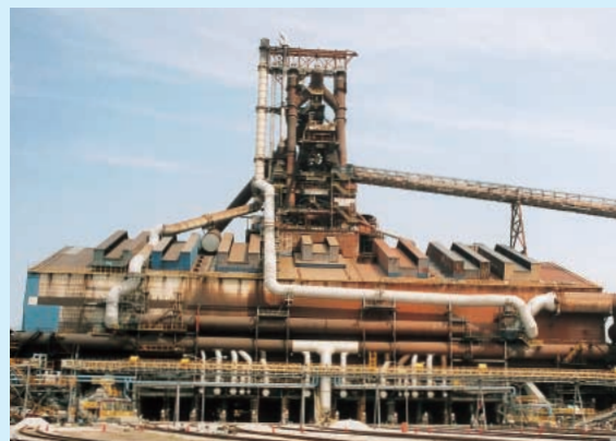
改修後の君津製鉄所 第4高炉 (本年5月8日火入れ)
