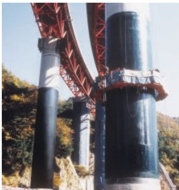
橋脚耐震補強工事
