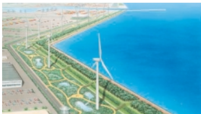
北九州市響灘風力発電事業の完成予想パース 10基で総出力15,000kWという規模は風力発電で西日本最大となる。 今年9月に着工、2003年3月から運転を開始し、九州電力に売電する予定。
