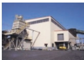
室蘭のプラスチックリサイクル設備
