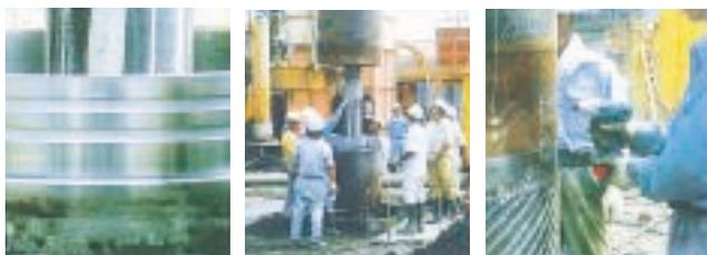
上端にピン継手を取り付けた杭を地中に建て込み、継手を清掃する。
