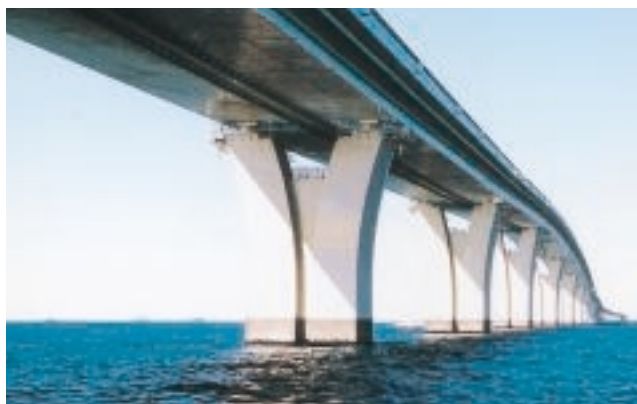
東京湾横断道路(アクアライン)橋脚
