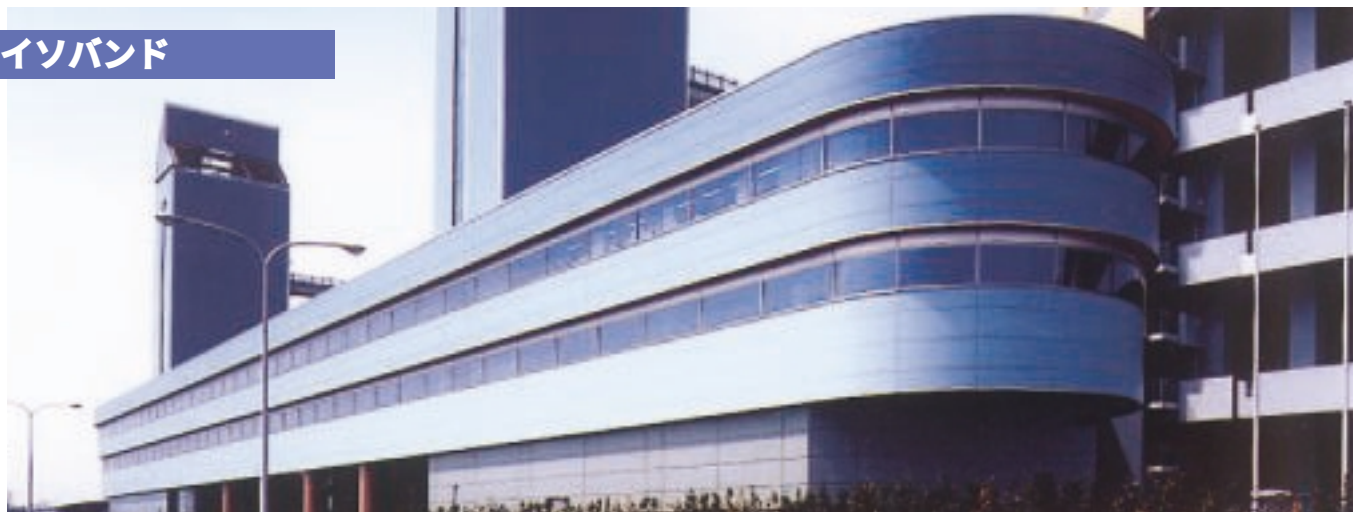
かわさきファズ物流センター事務管理棟（神奈川県）外壁（耐火イソバンドBL）
