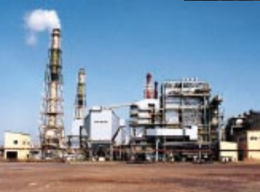
広畑の卸電力事業用発電設備
