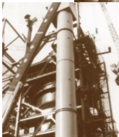
建設中の君津CDQ設備
