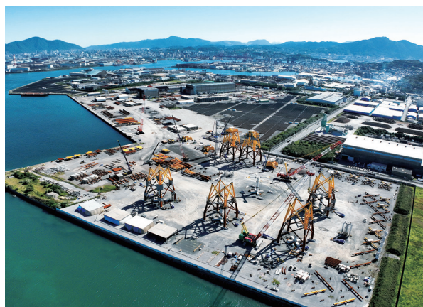
図16 日鉄鋼構造(株)で製作中のジャケット構造 Jacket structure under construction at Nippon Steel Steel Structure Co., Ltd.
