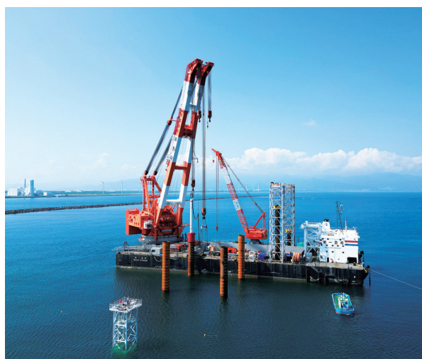
図15 現地海域での鋼管杭打設状況 Installation of piles at the site
