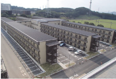
写真6 3階建て独身寮（出典：日鉄テックスエンジ(株)） 3-story steel framed dormitory
