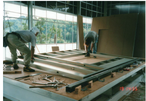
写真2 工場での構造パネル製作状況 Scene of structural panel production in factory
