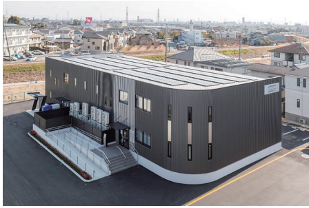
写真 8 NSSF 工法名古屋研修センター (出典：日鉄テックスエンジ(株)) Nagoya Training Center
