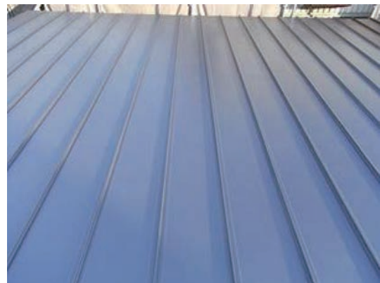
使用部位：屋根材 色：ギングロ（クールタイプ） 屋根形状：縦平葺き 屋根製品：(株)協和アールロック
