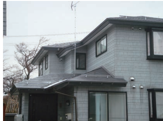
使用部位：屋根材 色：ギングロ（クールタイプ） 屋根形状：横葺き 屋根製品：(株)協和天晴ライナー
