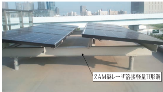
図18 ZAM製レーザー溶接軽量H形鋼の太陽光パネルの架台への適用例
