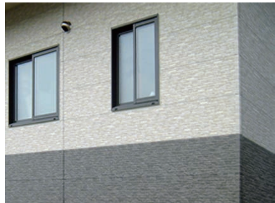
輝石グラジェット 段役物施工例
