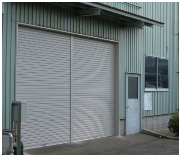
図 13 シャッター用 ZAM カラーの用途例(軽量シャッター) Fig.13 Applied example of the ZAM Color. (Light-weight rolling door for buildings)
