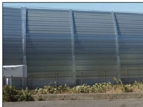
f) 低光沢処理(高速道路遮音壁・背面側)
