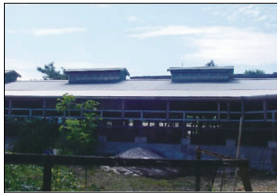
d) ZG処理(豚舎屋根・波板)
