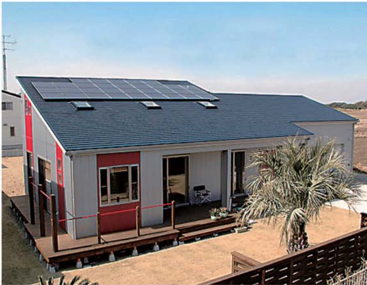
使用部位：屋根材 色：ギングロ（クールタイプ） 屋根形状：横葺き 屋根製品：月星商事株MSタフルーフ
