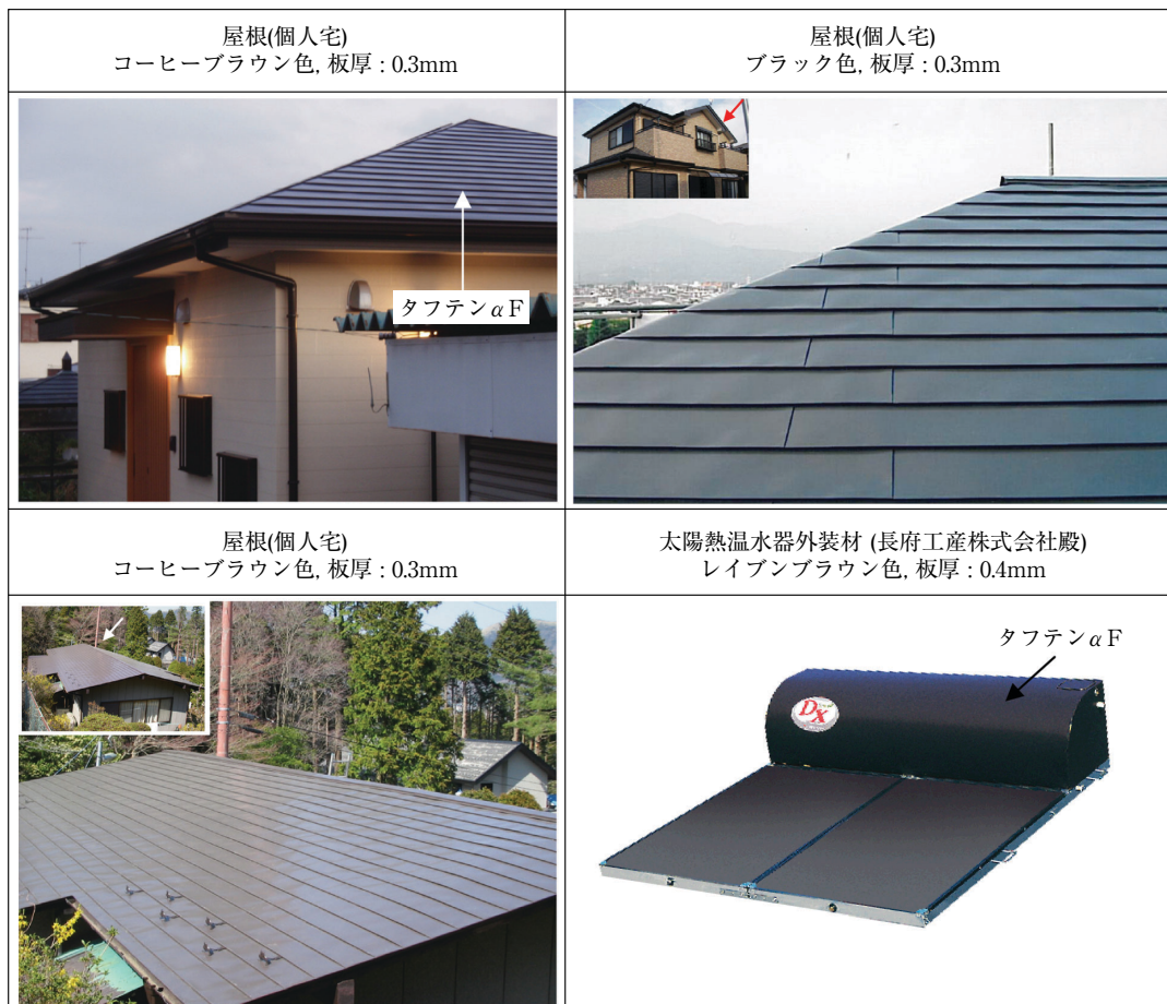
図6 フッ素塗装フェライト系ステンレス鋼板(タフテンαF)の外装建材への適用例
