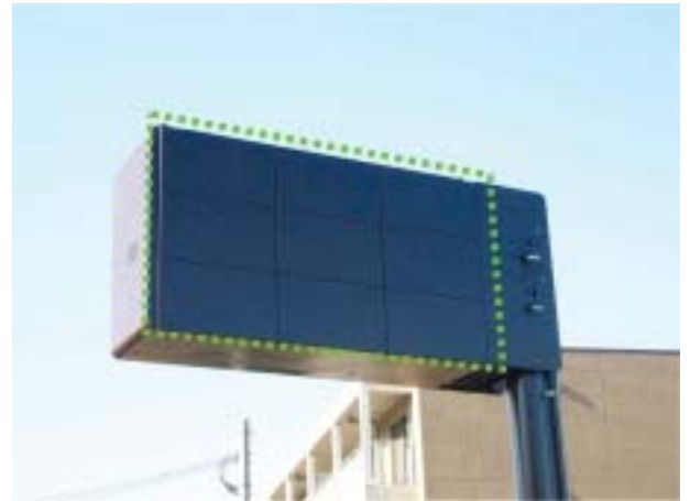
図11 開発材の用途例(道路情報板背面)
