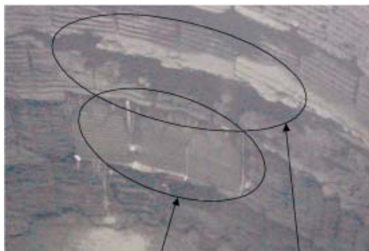
平成16年9月銅ステーブ化(S-2) S-3のうち損耗が激しいステーブ (平成17年3月に銅ステーブ化)
