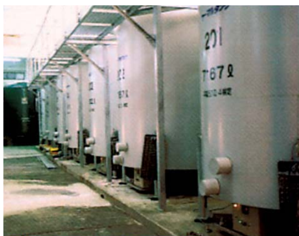
図1 酒貯蔵タンクの例(1kl級)
