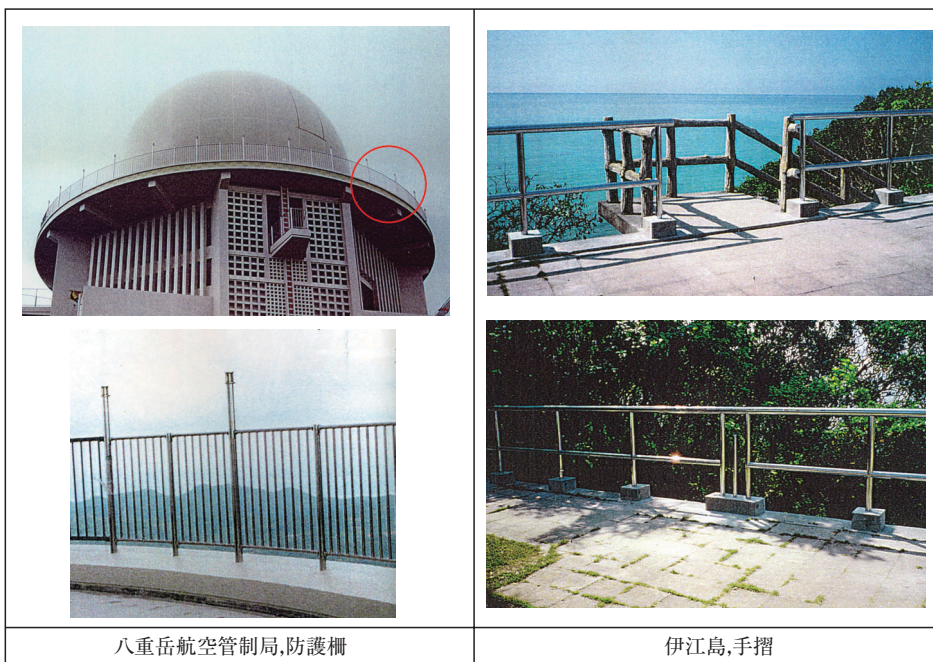
図8 NSS447M1装飾管の施工例(沖縄県,3年) Fig. 8 Applications of NSS447M1 ornamental pipes for fences and handrails (Okinawa,3years)
