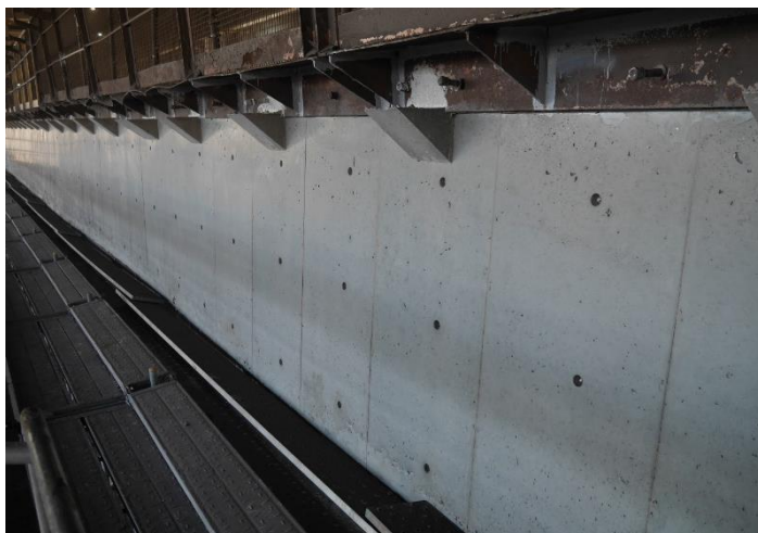
写真1 施工後の擁壁 (長さ 24.7m×高さ 1.3m×厚さ 10cm)
