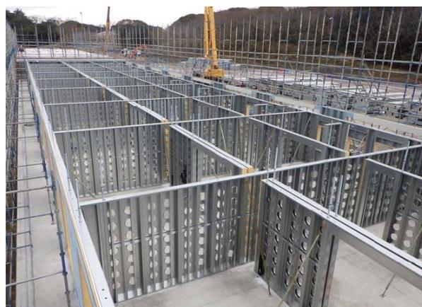
大和田社宅は2016年より更新整備を開始し、2017年までに竣工した2棟（100戸）を含め、昨年11月より建設中の4階建て集合住宅3棟（185戸）および3階建て集合住宅1棟（27戸）の全てで、日本製鉄が独自に開発したスチールハウス工法（NS スーパーフレーム工法®）を採用しています。
