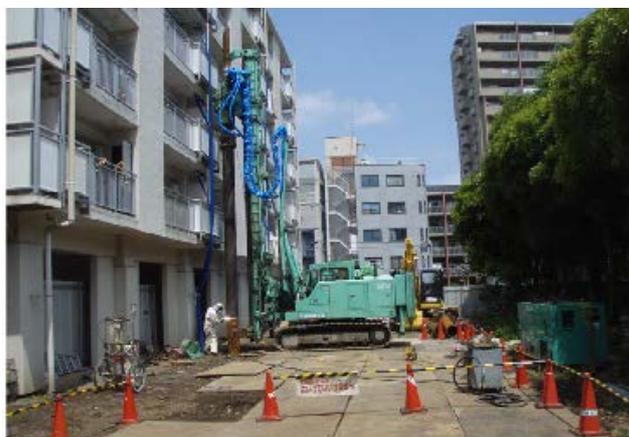
写真3 集合住宅耐震補強の狭隘地施工
