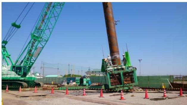
写真2 道路高架橋での斜杭施工
