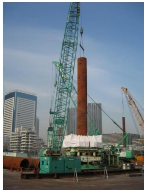
写真4 軟弱地盤上の高層マンションでの大深度施工
