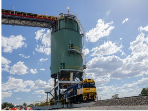
鉄道積込設備
