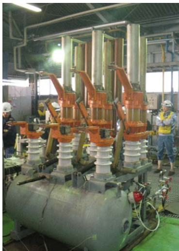
図 4.2 ABB の外観写真
